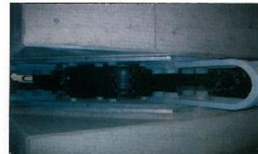
شکل ۱۱- ترکیب جداگر لرزه‌ای و دسیرهای فلزی منحنی
