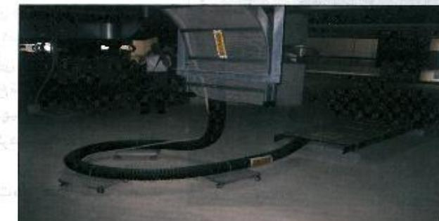
شکل ۱۰- جزئیات تاسیسات مکانیکی انعطاف‌پذیر در سازه‌های مججهز به جداگر لرزه‌ای
